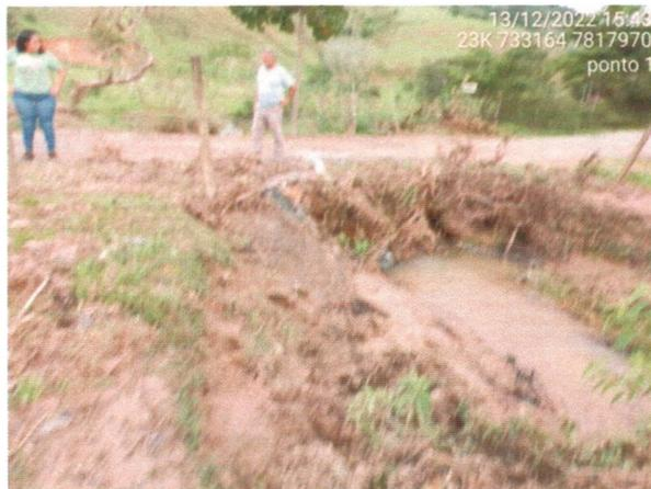
**Figura 10: saída do bueiro assoreada.** Data: 13/12 /22, Coordenadas UTM:23k 733164 7817970 .
