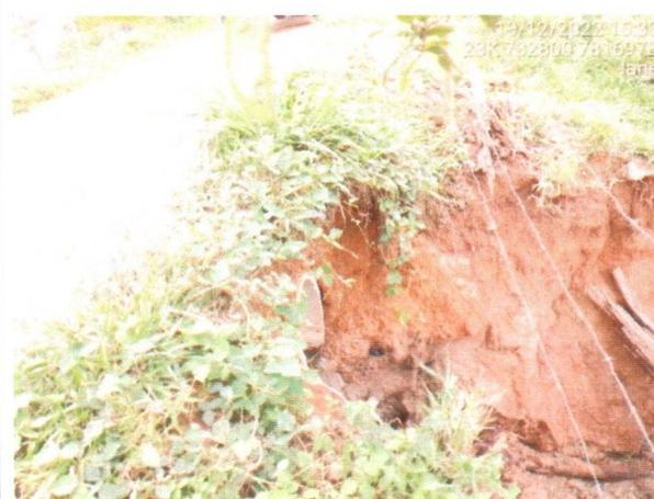
**Figura 13: avanço da erosão no sentido da estrada.** Data: 13/12/22, Coordenadas UTM: 23K 732800 7816973.
