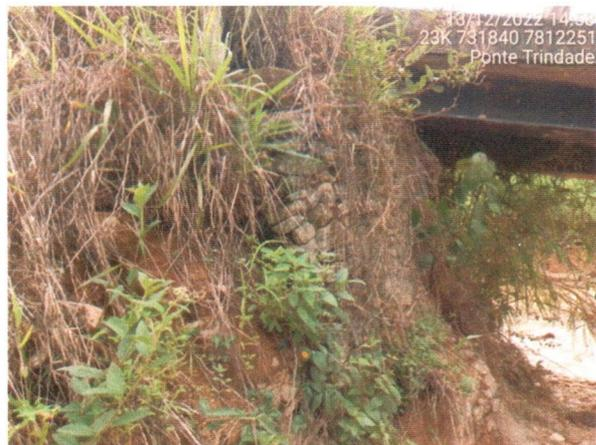
**Figura 05: apoio em gabião do lado oposto danificado.**,Data: 13/12/22, Coordenadas UTM: 23K 731840 7812251 .
