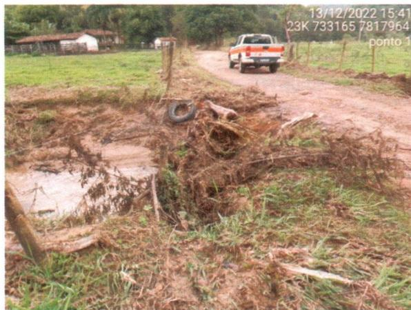
**Figura 09: margem da estrada danificada do lado da entrada do bueiro** Data: 13/12 /22, Coordenadas UTM:23k 733165 7817964.
