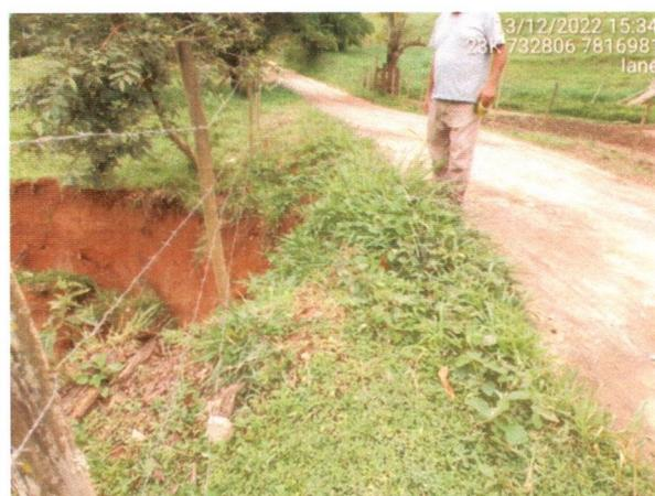
**Figura 12: aumento da erosão avançando para o leito da estrada.** data: 13/12/22, coordenadas UTM: 23k 732806 7816981
