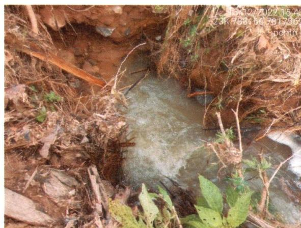
**Figura 08: entrada do bueiro com assoreamento** Data: 13/12/22 coordenadas UTM: 23k 733166 7817969 .
