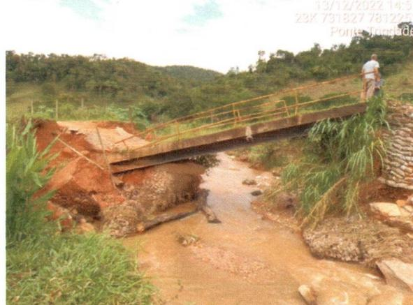
**Figura 06: vista geral da situação da ponte com os apoios em solo envelopado em situação de desmoronamento,** Data: 13/12/22,Coordenadas UTM: 23K 731827 7812251 .
